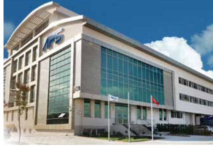
AFS Boru Fabrikası - Ankara
