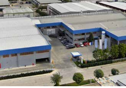
PFW Havacılık Fabrikası - İzmir
