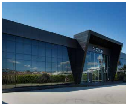
Selüz Kimya Fabrikası - Kocaeli
