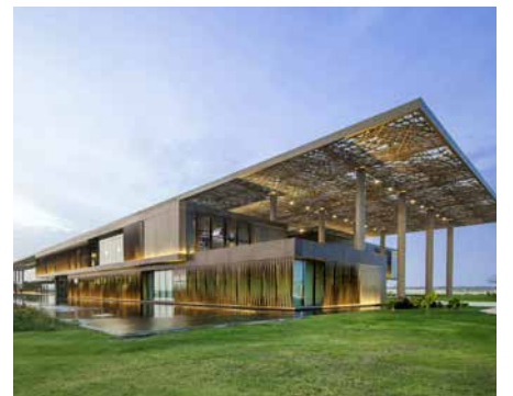
Data Center - Senegal
