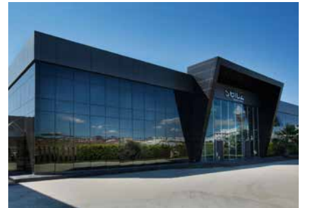
Selüz Kimya Fabrikası Kocaeli
